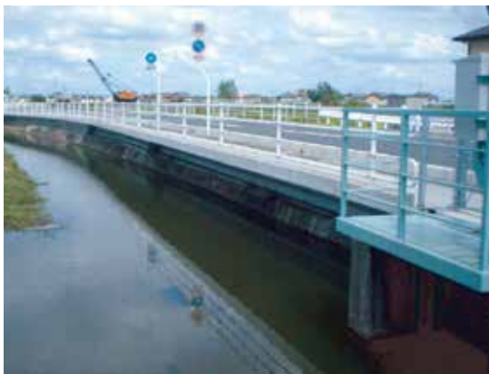
・県道藤戸早島線 (岡山)
