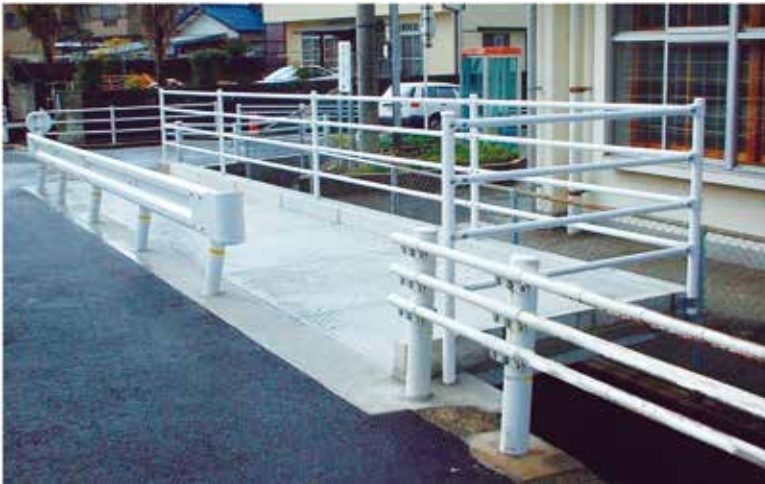
市道麻里布町3号線歩道設置工事
