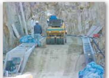
アンカー筋設置(D19 SD345)
