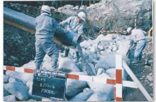
新粗石BSB工法とは、粗石コンクリート工法という既往の技術を基本にしながら、現場発生土の有効利用とコスト縮減、さらにCO<sub>2</sub>の発生的大幅な削減の観点から開発された砂防の新工法で、施工現場で発生した粗石を200mm～500mmに選別して事前に敷き詰め、敷き詰めた粗石の間に流動性の高いコンクリートを流し込み、砂防構造物を構築する工法である。
