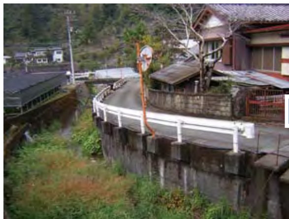
施主：高知県津野町役場 工事名：町道上法線
